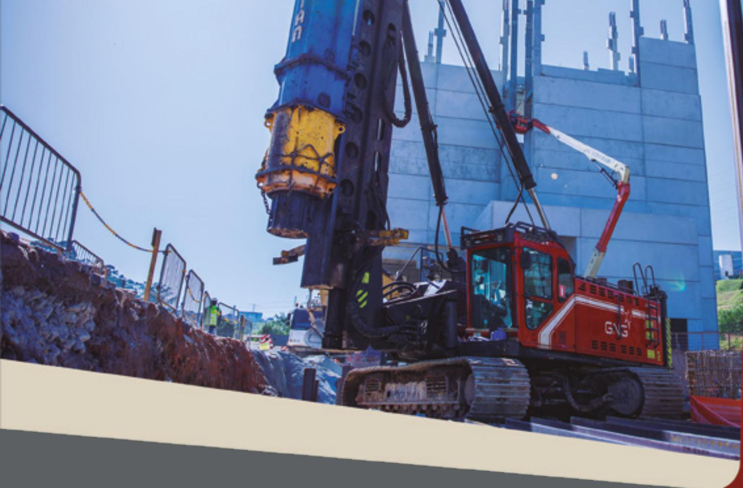
Com parque de máquinas equipado por dispositivos de alto nível, a GNG Fundações realiza projetos de médio e grande porte, como os de cravação de estacas de concreto, metálica e prancha, com ênfase em grandes seções e profundidades.
