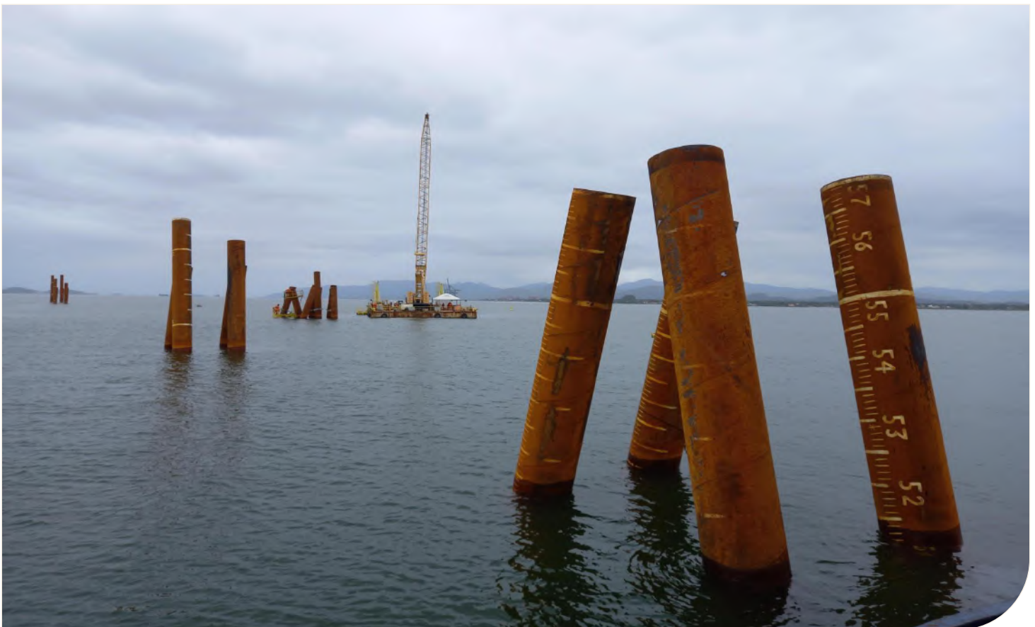
Terminal de Gás
