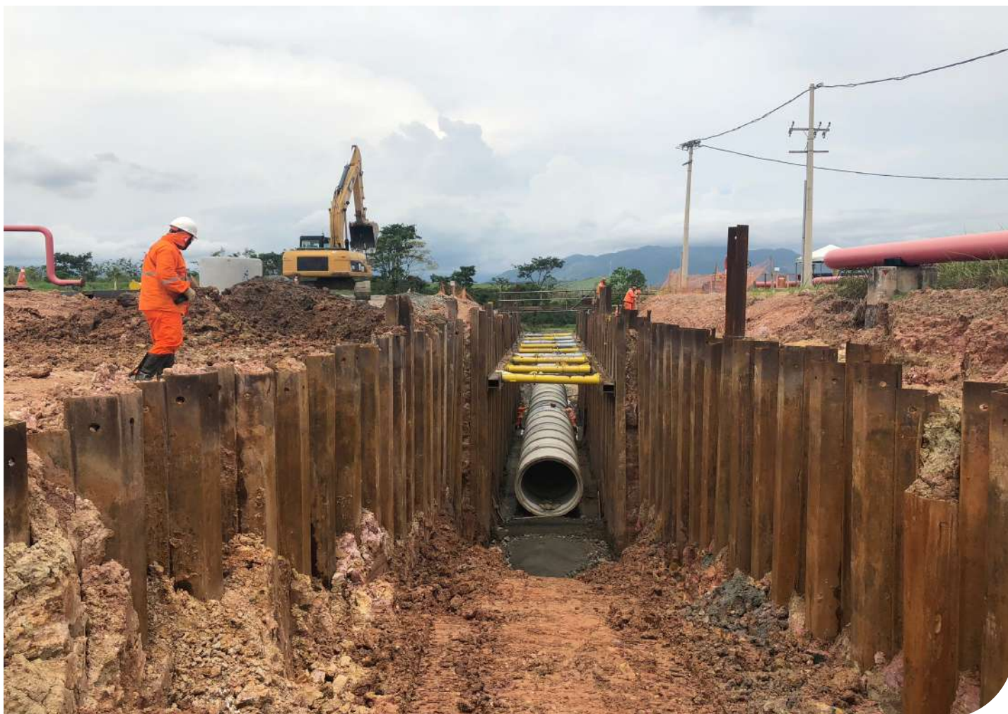
Escoramento de Vala
