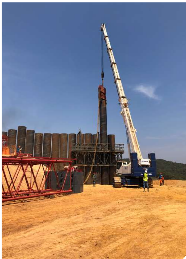
Martelo vibratório suspenso em guindaste Local: Itatiaiuçu, MG
