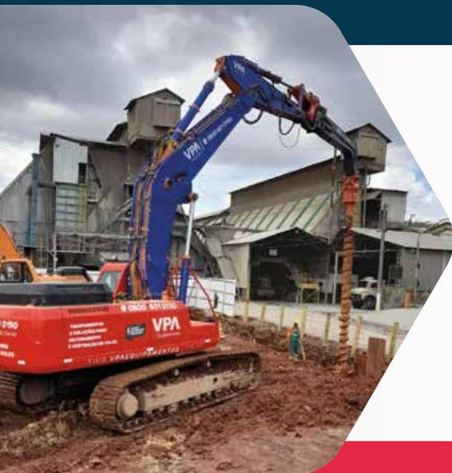
Solução rápida e econômica para escavação em terrenos mais duros, o **Drill Perfuratriz** é um implemento capaz de realizar pré-furos com até 9 metros de profundidade, facilitando a cravação de Estacas, Perfis, Trilhos e Tubos.
