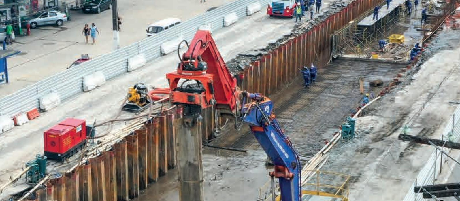
A escolha apropriada das Estacas Prancha envolve análises técnicas detalhadas, considerando o tipo de solo, profundidade da escavação, e pressões ambientais. Em muitos casos, é necessária a implementação de estroncamentos modulares para reforçar o sistema de contenção, especialmente em solos menos coesivos ou em situações de alta carga lateral.
