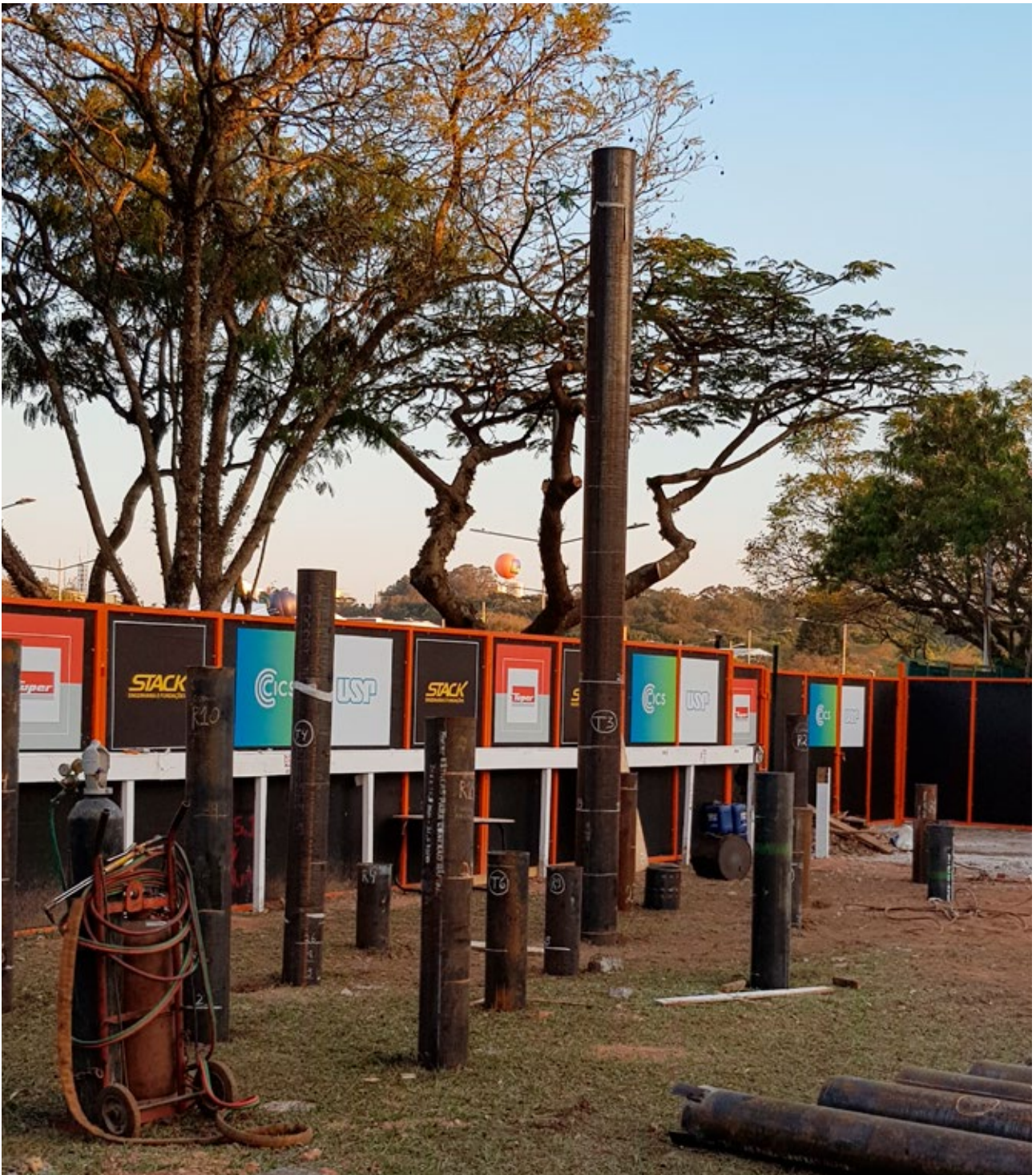
Figura 9.3 – Estacas cravadas no campo de provas do CICS – USP.
